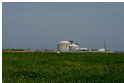
日立港 LNG タンク
